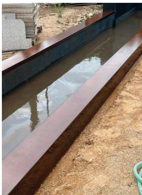
APRÈS APPLICATION DE METALCORTEN OXIDE + PROTECTOR
