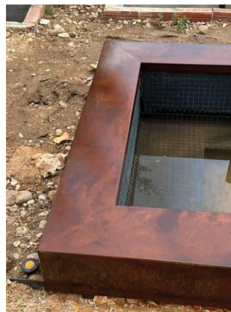
APRÈS APPLICATION DE METALCORTEN OXIDE + PROTECTOR
